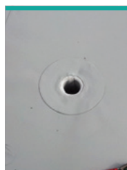
배관 주변 시공
